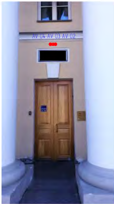
Размещение видеокамер в осях А-5, А-6
