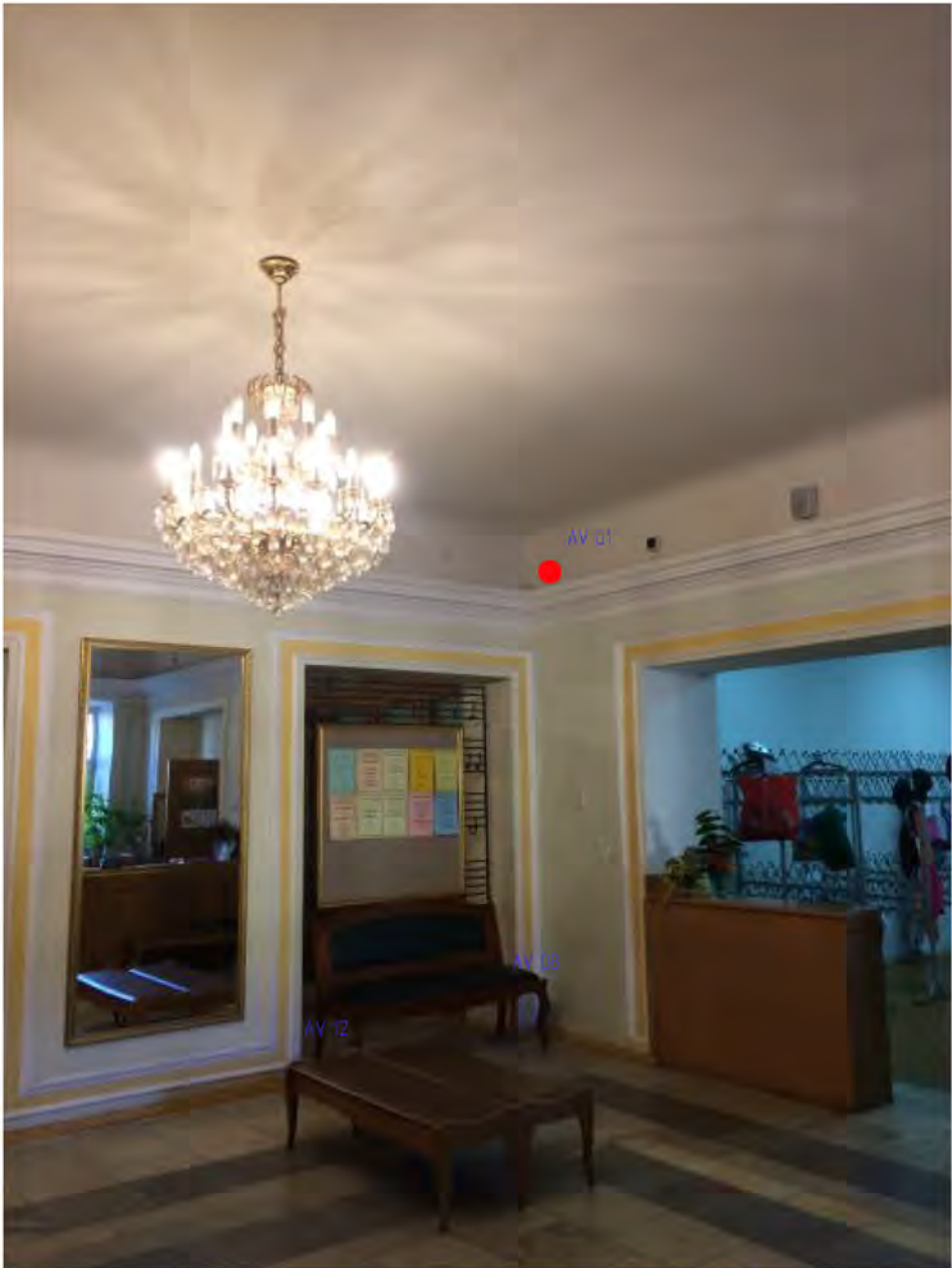
Фотосхема размещения видеокамеры в осях Б-6
