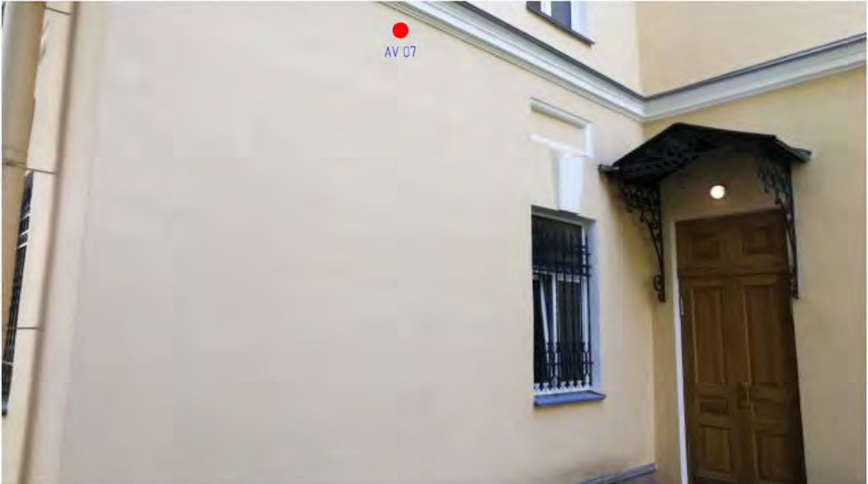
Размещение видеокамер в осях Г-1, Г-2
