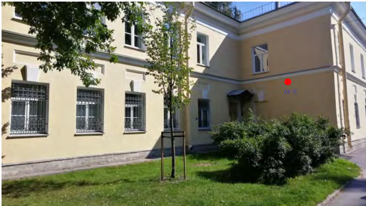
Размещение видеокамер в осях Г-9, Г-10
