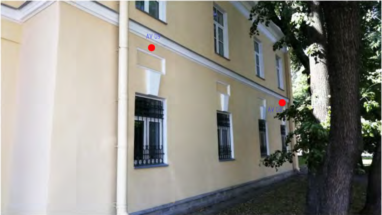
Размещение видеокамер в осях Г-1, И-1
